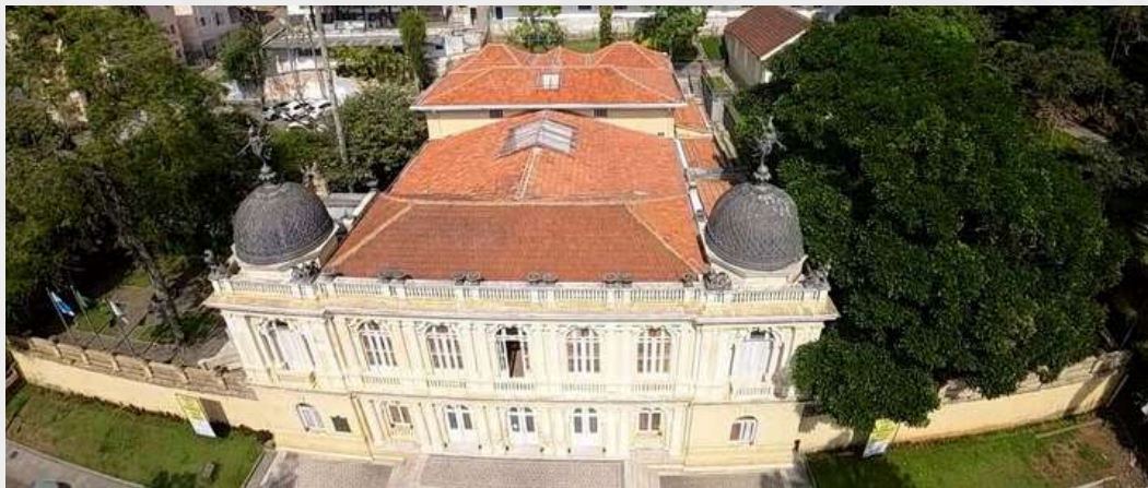
Vista área do telhado
