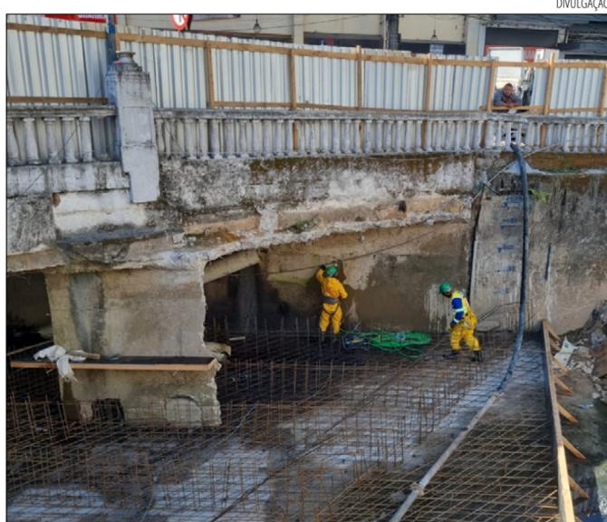
TRABALHADORES fazem a concretagem do túnel extravasor e instalam as com-
