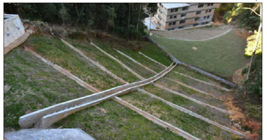
ENTRE AS obras entregues está a contenção no BNH do Sargento Boening
