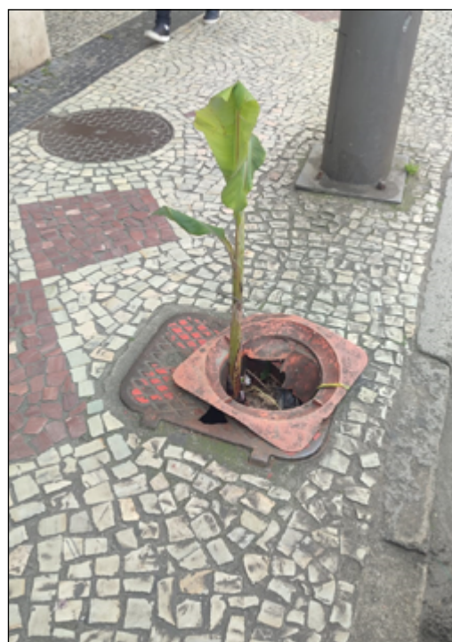
TAMPA quebrada pode causar acidentes
