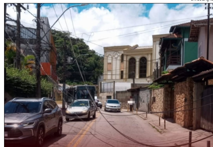
OS FIOS ficaram caídos e impediram a passagem de ônibus
